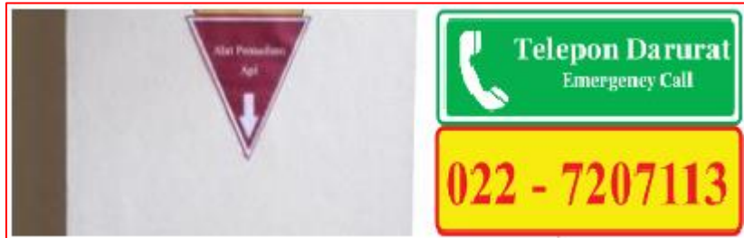
Gambar 8.14 Display Alat Pemadam Kebakaran dan Nomor Telp Pemadam Kebakaran
