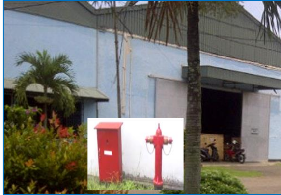
Gambar 3.17 Contoh Pemasangan Hydrant
