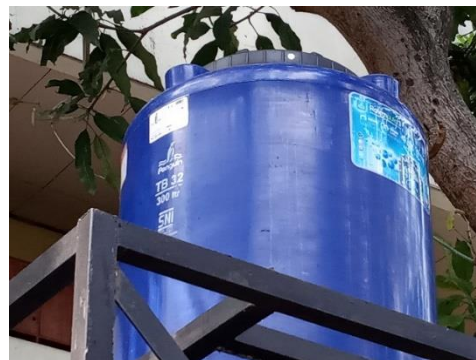
Gambar 4.23. Penampungan air (torn) di bagian atas menara
